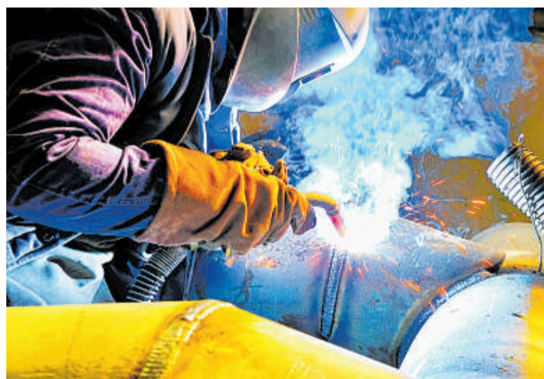
Auch im Hamburger Vattenfall-Kraftwerk waren Schweißer des Herner Unternehmens Enitec im Einsatz.
